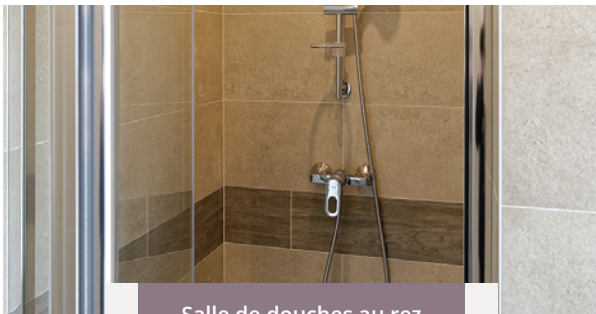
Salle de douches au rez
